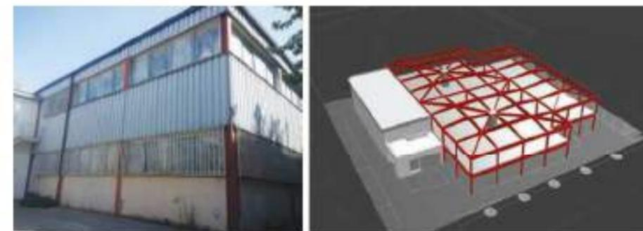
3D STRUTTURE IN ACCIAIO ESISTENTI
