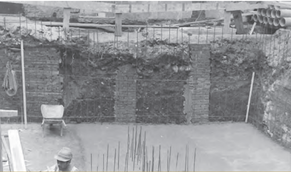
Foto dei lavori di ristrutturazione
